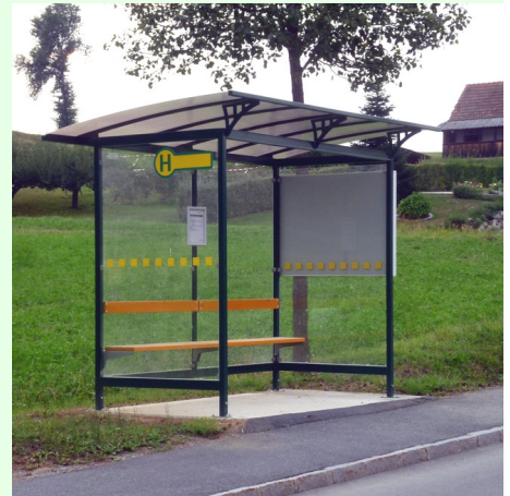
Neues Warthäuschen aus Glas im "Dorf"
