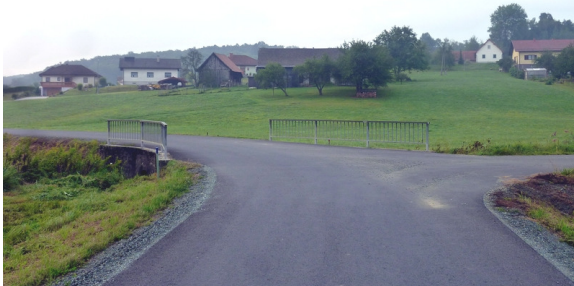
Der sanierte Güterweg im "Dorf" Richtung Langzeil
